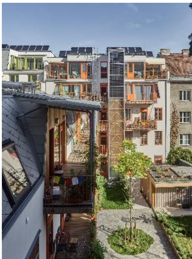
6.15: Chytrý blok Geblergasse ve Vídni, navržený společností Zeininger Architekten Technical (2021), získal Státní cenu za architekturu a udržitelnost. Blok zahrnuje téměř 20 parcel. Stávající domy byly rozšířeny, zvýšeny a renovovány a poprvé v Rakousku byla v historických budovách využita geotermální energie © BMK/Kurt Hoerbst
