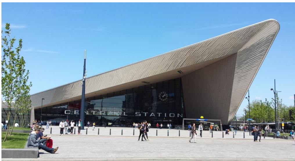
5.27: Nový vchod do rotterdamského hlavního nádraží, prosazený městem Rotterdam a navržený kanceláří Sjoerda Soeterse, dokončený v roce 2014 © João Bento.
