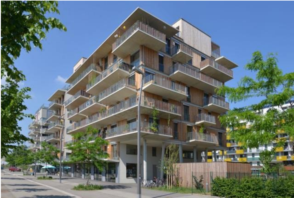
6.17: Bytový komplex v Bednar Parku, Vídeň – dotovaný dům s 39 bytovými jednotkami, společenskými místnostmi o rozloze 500 m 2 a komerčními jednotkami o rozloze 400 m 2 , vítězný projekt developerské soutěže Nordbahnhof, plánovací období 2010-2013 a dokončení konec roku 2013, navrženo atelierem Einszueins Architektur © MA19
