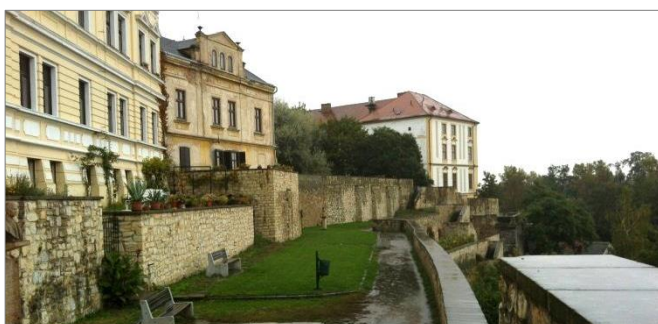
Obr. 18: Litoměřice – městské hradby a parkány. Původní litoměřické hradby zanikly beze stop. Dnešní gotický systém vznikl ve dvou etapách. Vnitřní hradba opatřená zubatým cimbuřím a hranolovitými věžicemi pochází z doby kolem roku 1360–1380. Vnější parkánová zeď s baštami ve tvaru podkovy byla postavena kolem roku 1513.
