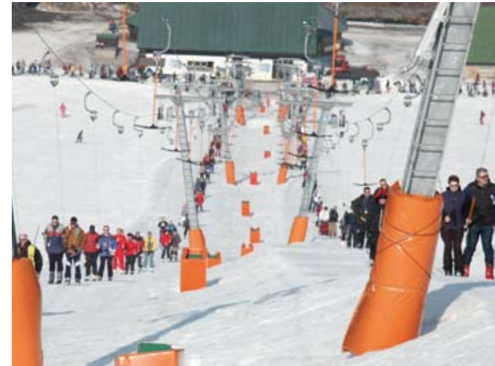
Příklad zajištění bezpečnosti provozu bezpečnostními matracemi
