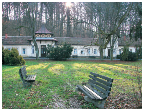
Budova původních lázní
