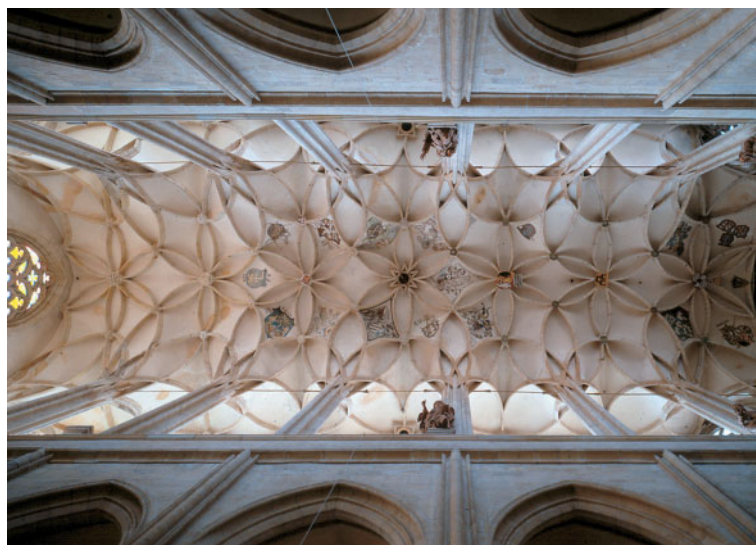
Strop chrámu sv. Barbory v Kutné Hoře
