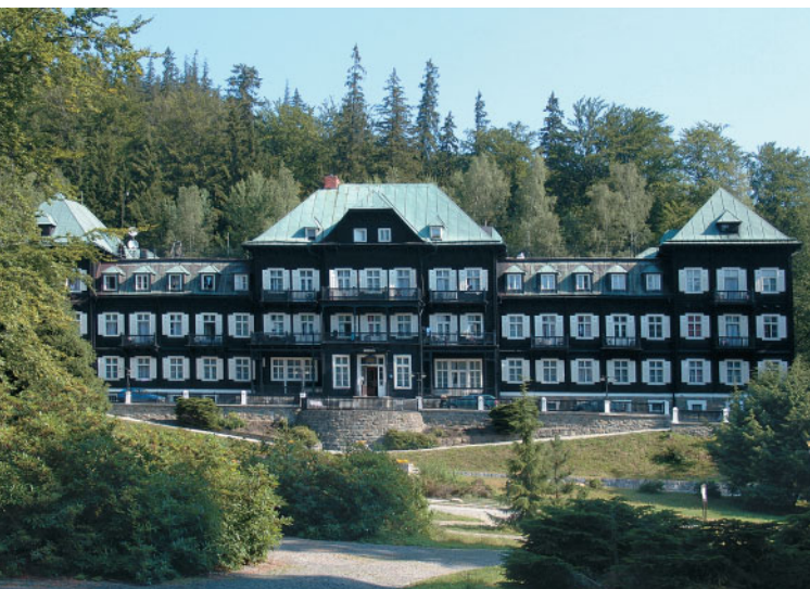
Hlavní lázeňská budova
